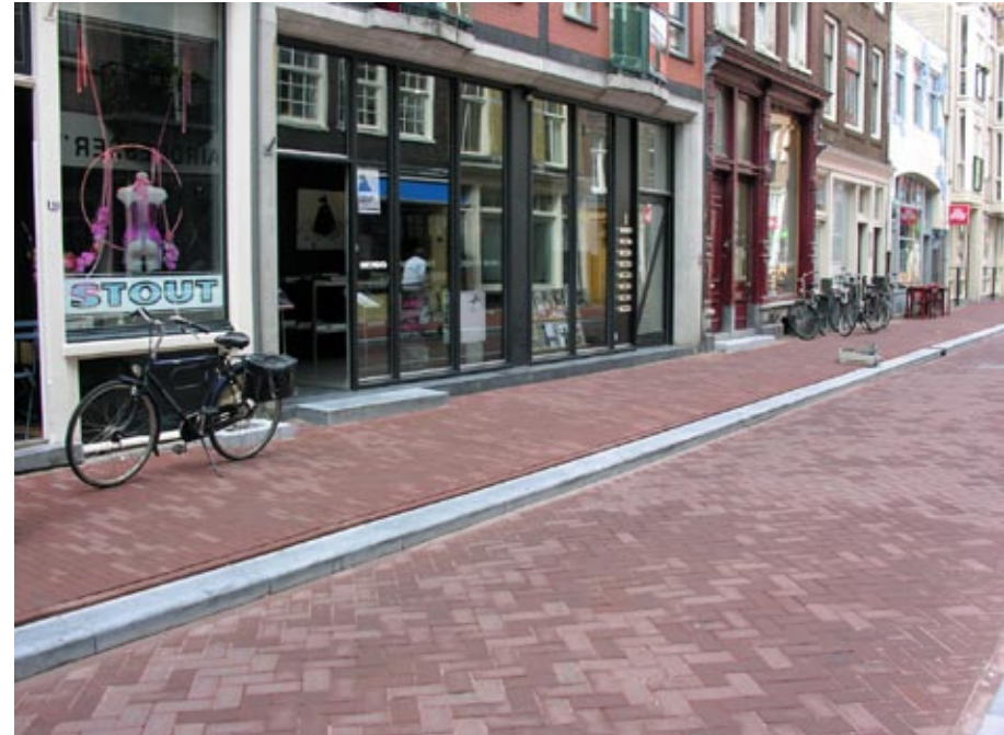
4.1 Klinkerbestrating met natuurstenen banden
